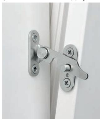
Проветриватель может устанавливаться на поворотных и поворотно-откидных окнах из ПВХ и дерева. Он имеет два паза, которые позволяют фиксировать створку в двух разных положениях.
