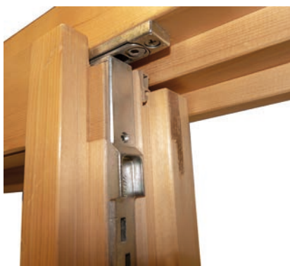
Otwarte szczeliny pomiędzy pierwszym i drugim skrzydłem są słabymi punktami konstrukcji
