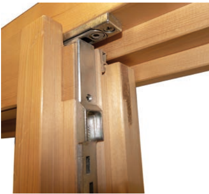
La fuga abierta entre la hoja activa y la pasiva es un punto débil
