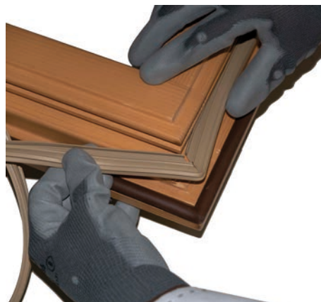
Montar la junta de goma
