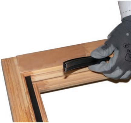
Leichte Überlänge beim Abschneiden einplanen, damit die Enden in den Ecken eingepresst werden
