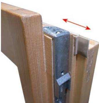
Das Endstück korrekt positionieren
