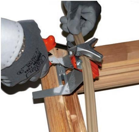
Dichtung in der korrekten Position klinken
