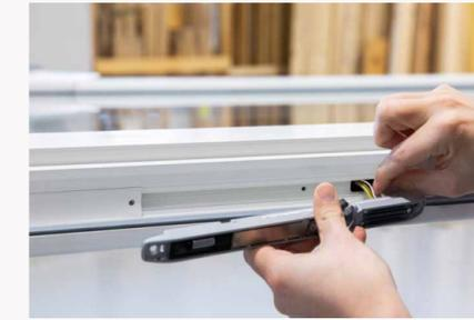
Paso 2: Conectar los componentes de cierre y colocarlos en el canal de herraje
