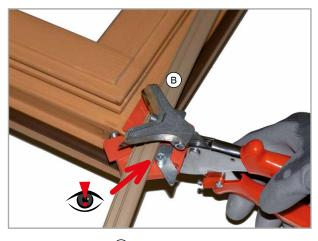
2. Placer le joint <sup>®</sup> dans la pince à onglet et le découper.
