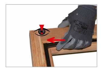
2. Lors de la mise en place, vérifier la pression sur le joint d'étanchéité veiller à ce que la pression soit suffisante.
