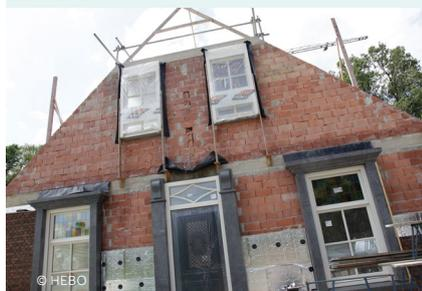
Устанавливается готовая рама и шумоизоляция, а внешняя кирпичная стена строится вокруг рамы. Это позволяет обеспечить хорошую герметичность всех технологических узлов оконного проема.
