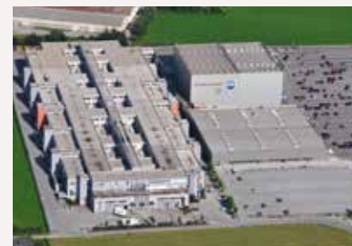
Centrum logistyczne grupy MACO-i bezpieczne miejsce pracy dla blisko 1000 pracowników: zakład produkcyjny MACO Trieben założony w 1994 roku.
