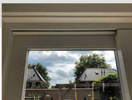
Rail supérieur dissimulé Pas de pont thermique ni de courant d'air gênant. En raison de sa valeur d'isolation thermique élevée, le système de levant-coulissant MACO peut être inclus dans la conception d'une maison passive.
