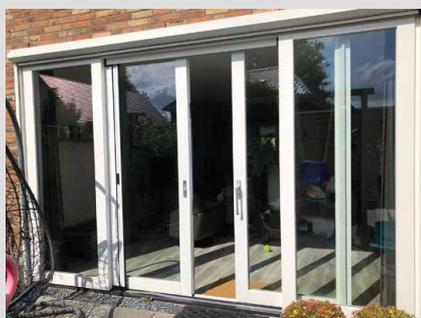
Un best-seller qui a fait ses preuves en matière d'efficacité énergétique et de sécurité : la porte coulissante en Meranti avec la quincaillerie, le joint central de 28 mm et le seuil GFK. Un confort de vie parfait et une utilisation facile.
