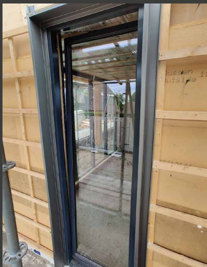
Raamdeur met MACO Multi Power-Beslag. Ventilatieschaar in zomerstand.
