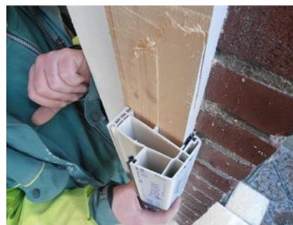
Bij het vervangen van de kozijnen van de woningen is het bestaande kozijn doorgezaagd en is de laatste 2 cm rondom gebruikt als stelkozijn voor de kunststof kozijnen.
