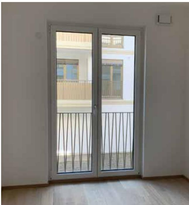
На 95% все окна состояли из элементов от пола до потолка, которые были оснащены многослойным безопасным стеклом в соответствии со стандартом. Для больших габаритов были использованы элементы фурнитуры Multi Mammut от MASCO, объясняет Маттиас Бухеггер, руководитель проекта в Heuberger Fenster (Fensterbau Salzburg).
