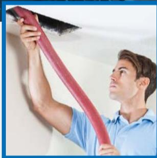
! KWL-Lüftungsanlagen zu reinigen, ist mit erheblichem Aufwand verbunden und kann oftmals nur von Fachfirmen ausgeführt werden. Bei fehlender Wartung sind die Folgen fatal: Die Lüftungsleistung nimmt ab, der Stromverbrauch der Anlage steigt und es strömt durch Schmutzpartikel verunreinigte Luft ein.
