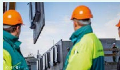
Le châssis de fenêtre une fois finalisé peut également être installé rapidement sur des murs intérieurs en béton. Plus les fenêtres ou les portes sont préfabriquées spécialement pour le bâtiment correspondant, moins le risque de connaître des dommages de construction est élevé.
