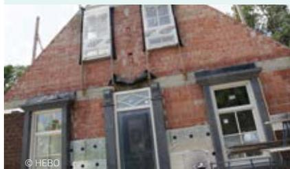
Le cadre prêt à l'emploi est positionné, l'isolation est posée et le mur extérieur en briques est construit autour du cadre. Cela permet de raccorder le cadre de manière étanche à l'air pendant l'installation, et d'assurer ainsi une étanchéité parfaite.
