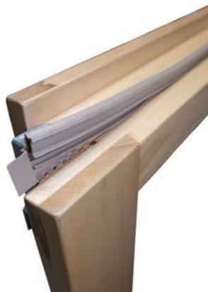
Insérer les pièces d'extrémité avec le joint dans la rainure
